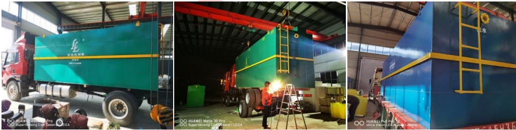
生活污水设备安装通水
